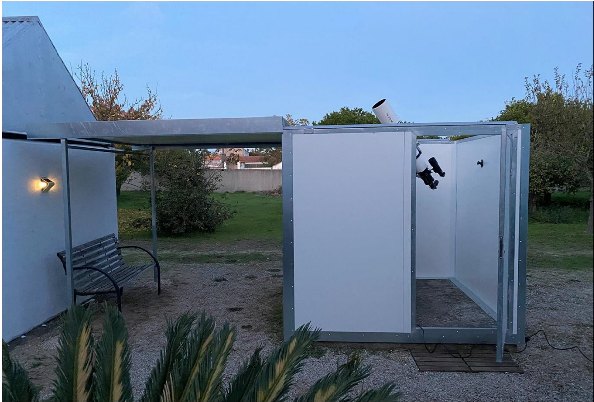
Figura 8- Observatório de tecto de correr.
